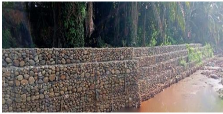
Gambar 1. Tembok Penahan Tebing Sumber : Dokumentasi Peneliti, 2022
