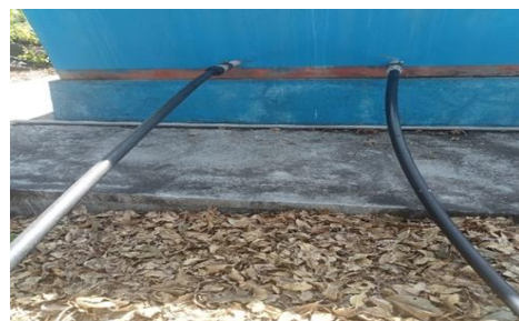
Gambar. 2 Pipa Air Desa Nobo
